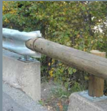
800 408 Raccordement sur glissière métallique
