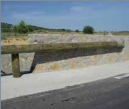
800 460 Raccordement sur muret
